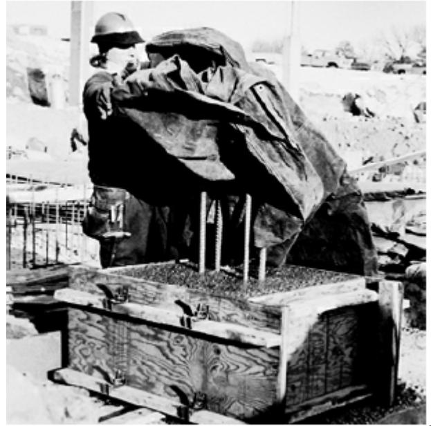
Resim – 2 : Bir temel ayağının plastik örtü ile korunması
